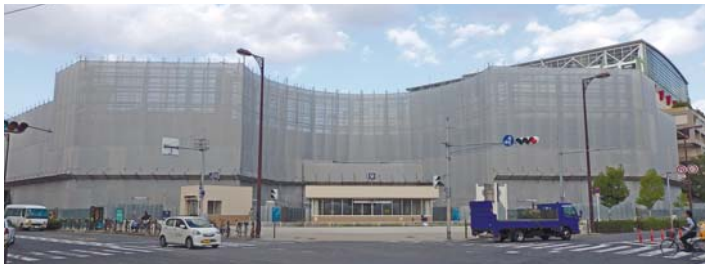
現場では急ピッチで工事が進む。中央部分は地下鉄動物園前駅直結の出入口、右奥の建物は「スパワールド世界の大温泉」
